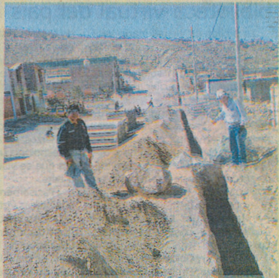
OBRAS DE SANEAMIENTO en Arequipa y provincias.
