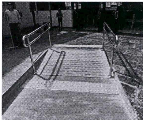
Figura N° 19. Barandas en rampas aisladas.
